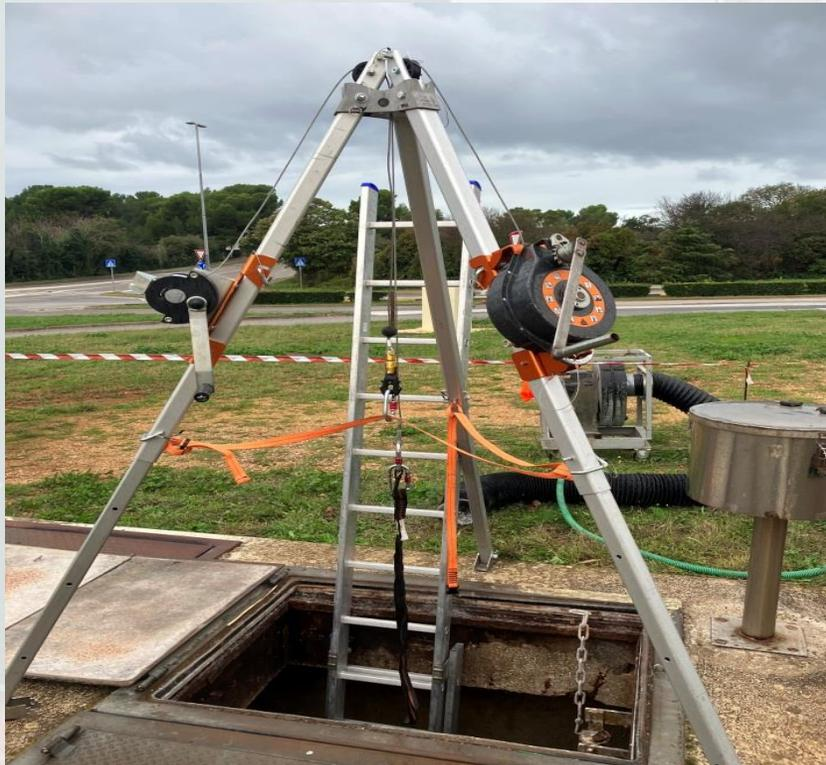
Naprava za zaustavljanje pada s uvlačivom sajlom, sidrište
