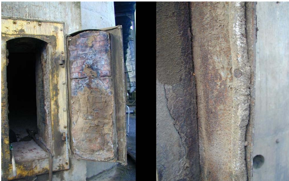
Slika 4.12 Brtvljenje azbestnim užetom na vratima dimnjaka. Slika s desne strane je pogled na uže izbliza.
