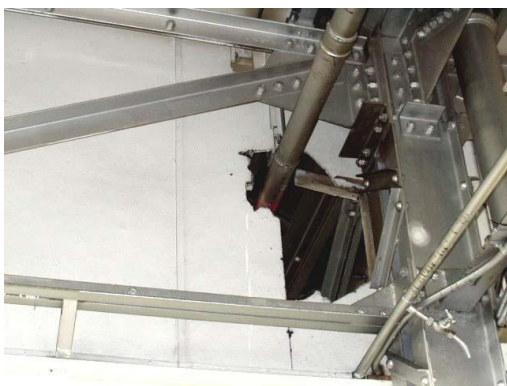
Slika 4.3 Pregradni zid izolacijske ploče od azbesta. Ovaj primjer ilustrira praktične poteškoće u izgradnji odgovarajućeg ograđenog prostora te također prikazuje površine na kojima se azbestna prašina može skupljati tijekom postupka uklanjanja.
