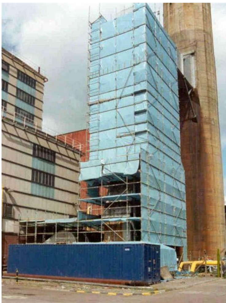
Slika 12.3 Ograđeni/zatvoreni prostor za uklanjanje izolacije iz dimovodnog kanala
