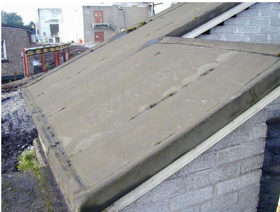
Slika 4.7 Azbestni krovni filc
