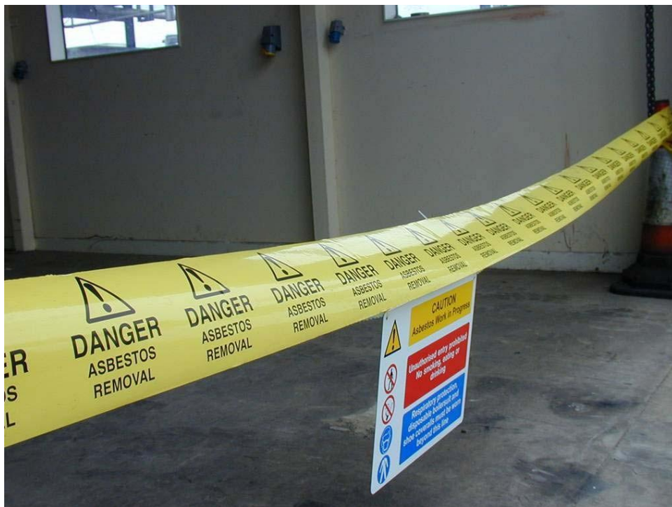
Slika 11.1. Upotreba trake upozorenja i znakova za odvajanje područja
