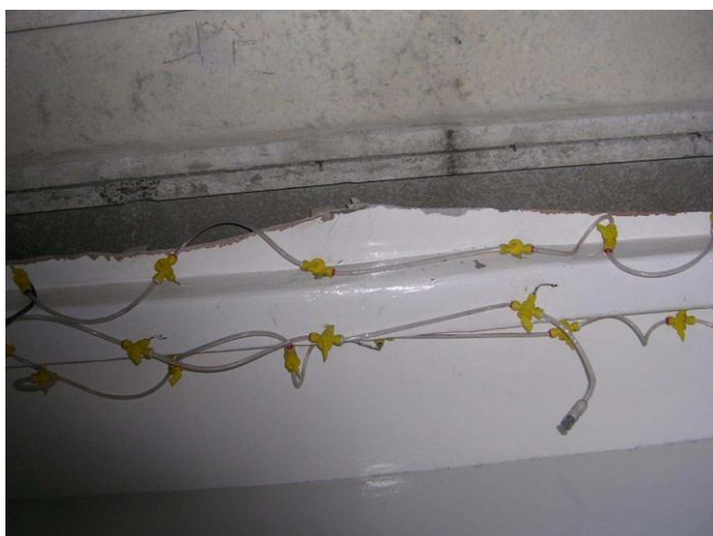
Slika 12.10 Primjer injektiranja u više točaka koje se koristi za vlaženje prskane azbestne izolacije.
