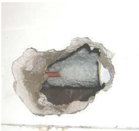
Slika 4.3 Pregradni zid izolacijske ploče od azbesta. Ovaj primjer ilustrira praktične poteškoće u izgradnji odgovarajućeg ograđenog prostora te također prikazuje površine na kojima se azbestna prašina može skupljati tijekom postupka uklanjanja.
