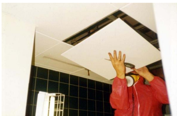
Slika 12.13 Pažljivo uklanjanje azbestne ploče
