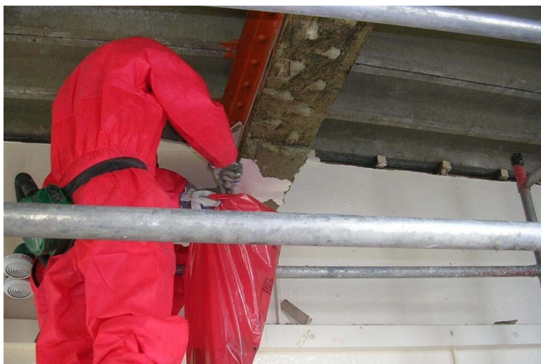
Slika 12.11 Pakiranje otpada u vreće blizu mjesta uklanjanja kako bi se spriječilo širenje i smanjila izloženost azbestu.
