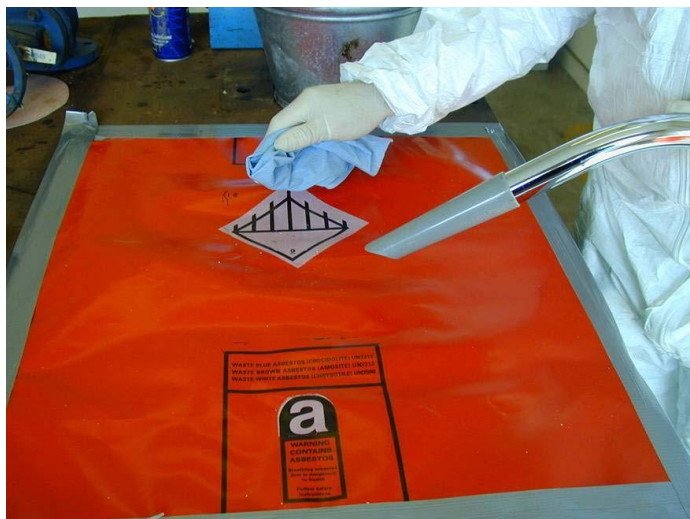
Slika 11.7 Pažljivo čišćenje radnog područja usisavačem tipa H i mokrim krpama za jednokratnu upotrebu.
