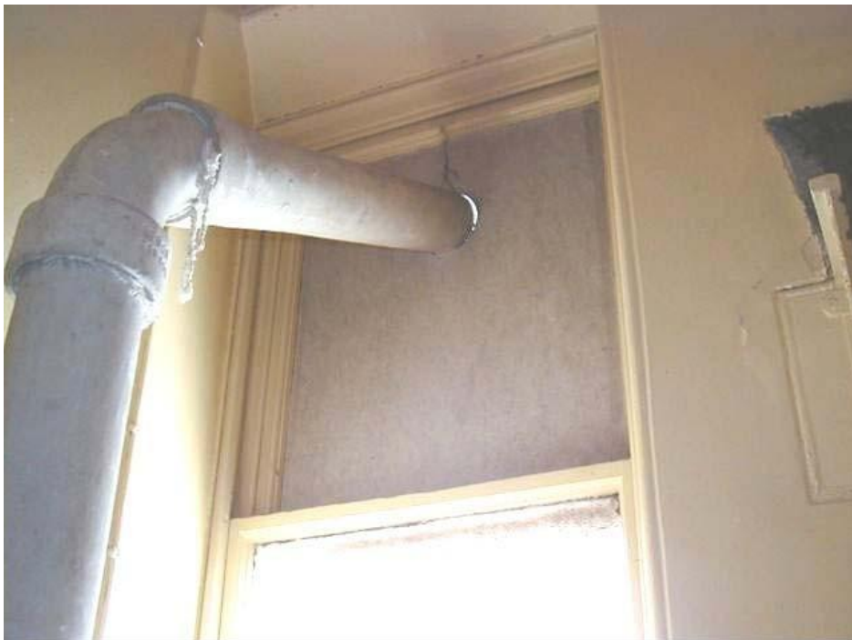
Slika 4.5 Azbestno-cementni dimovod s brtvama od azbestnog užeta koji prolazi kroz ploču s azbestnom ispunom.
