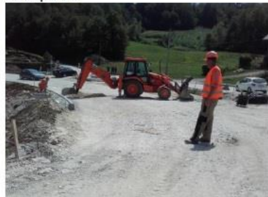
a) kopanje kanala preko ceste, regulacija prometa putem signaliste
